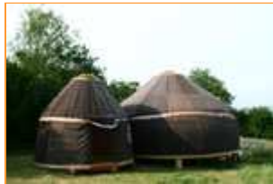
Isolation laine de l'ensemble
