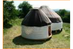
Isolation laine du toit
