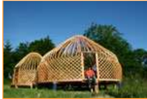
Montage des voûtes
