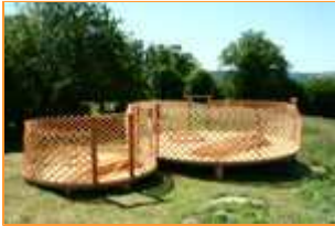
Montage des murs
