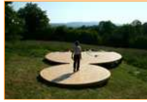
Panneaux OSB et feutre de chanvre sur plateforme
